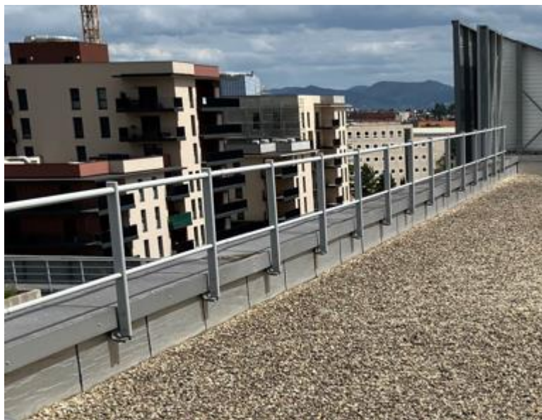
La toiture est Sécurisée par garde-corps
