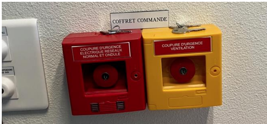
Figure 6 : Arrêt d'urgence principal dans le poste de sécurité du site au RDC (à l'ouest du bâtiment, voir figure précédente). L'arrêt d'urgence solaire sera placé ici.
