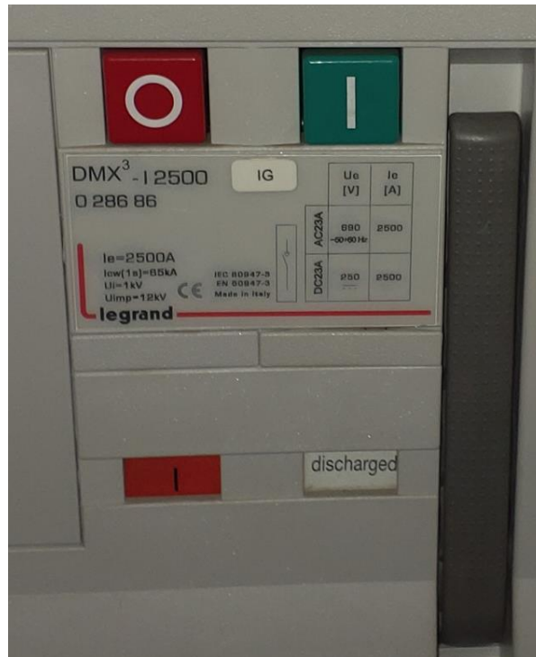
Figure 2 : Le disjoncteur général BT du site.
