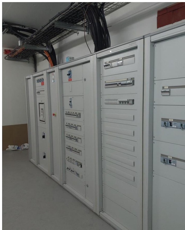
Figure 3 : Armoires électrique du TGBT
